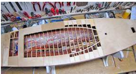
Sperrholzdeck mit Verstärkungen
