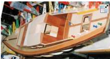
Sperrholzdeck mit angefangener Birnbaum-Beplankung
