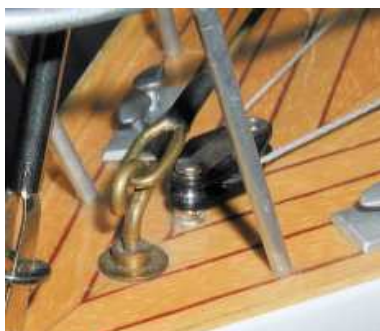
Bild 2: Mit Hilfe der Messingdübel und VA-Schrauben entstehen hochfeste Befestigungspunkte. Links ist der Dübel im eingeharzten Zustand gezeigt und auf der rechten Seite ist der aufgeschraubte Umlenkblock zu sehen.
